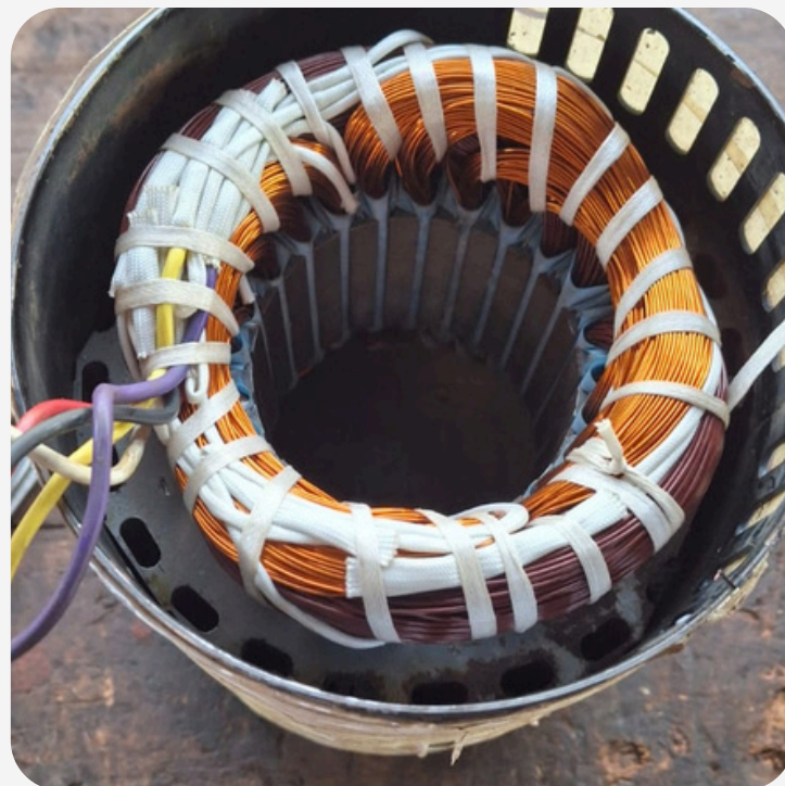
Reboinado de motores
