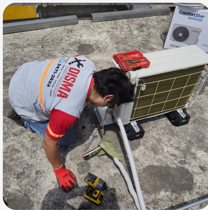
Instalacion de aire acondicionado
