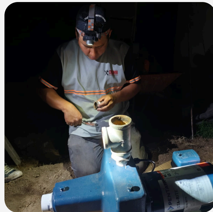
Bombas de distribuciones
