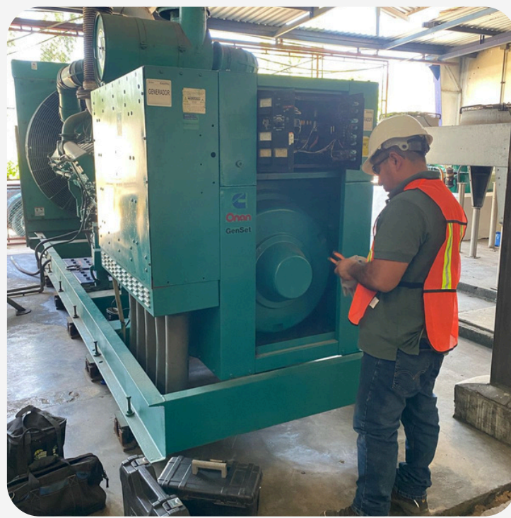
Reparacion y mantenimiento de generadores
